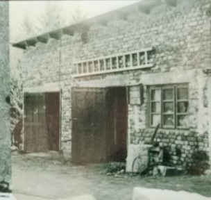
Strojovna lomu Hluboká, místo úkrytu radiostanice Libuše
